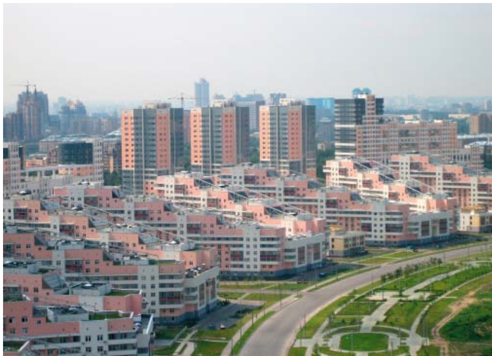
Panelové domy, Moskva, RU
